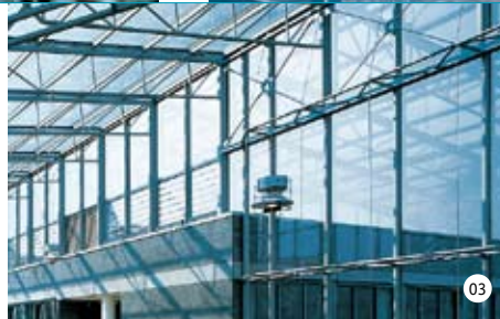
03. VR Leasing, Eschborn. 04. In einer punktgehaltenen Fassade ist INFRASTOP® die optimale klimatechnische Ausstattung im Hotel atoll, Helgoland.
